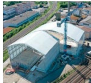
Die Ästhetik und Leichtigkeit der Hallenbau-Konstruktionen machen Membranbauten vielseitig einsetzbar und ermöglichen enorme Spannweiten in ökonomischer und ökologischer Bauweise.
