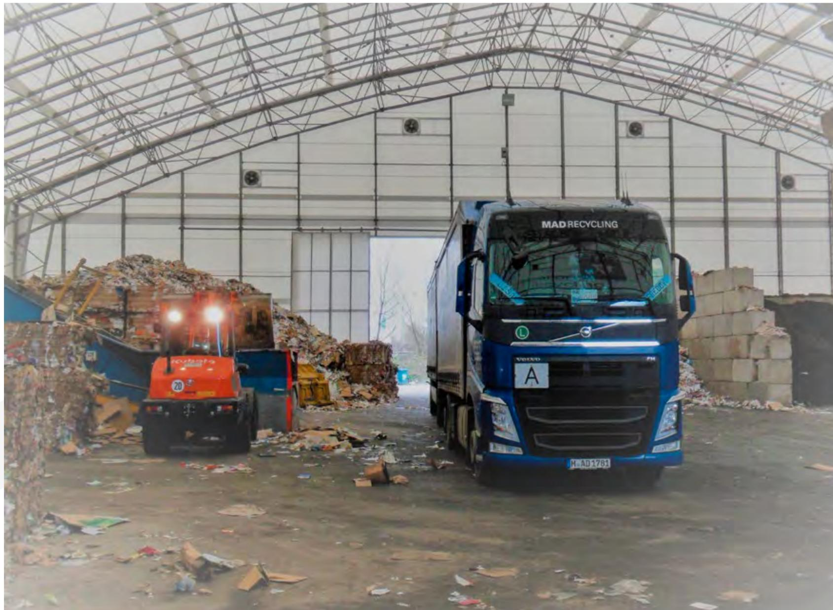
MODULAR Hallen werden mit einem für Ihre Anwendung abgestimmten elektrischen Be- und Entlüftungssystem ausgestattet und sorgen somit für optimale Verhältnisse im Halleninneren. Standardmäßig werden Axialventilatoren mit einer theoretischen Luftwechselrate von mind. 1/h realisiert.
