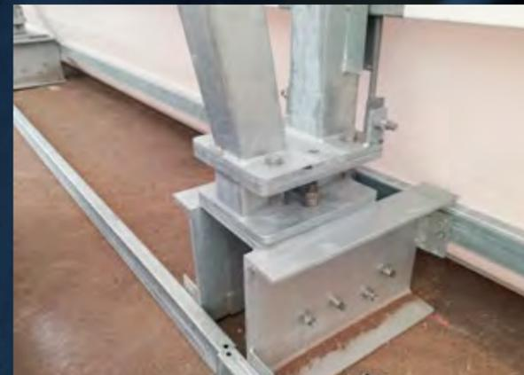
Verankerung auf Asphalt (Injektionsanker)
